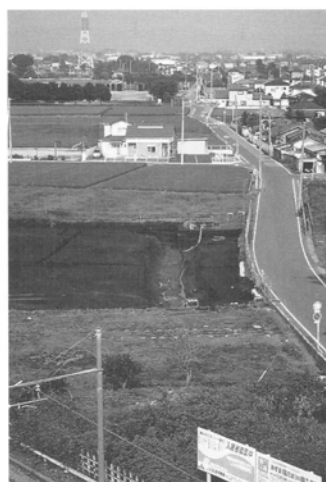
北区遠景 西から
