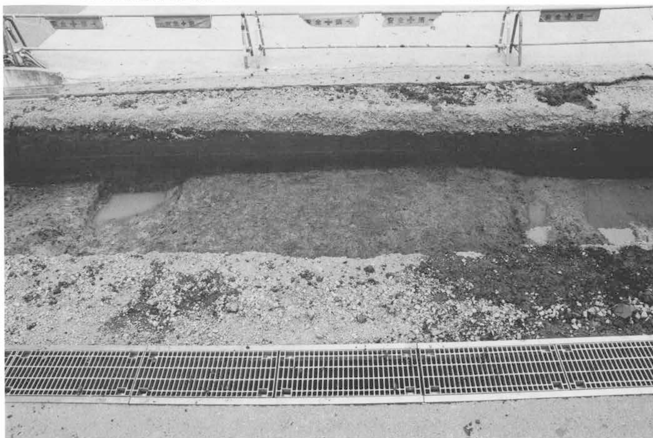
4. A区推定東山道（東から）
