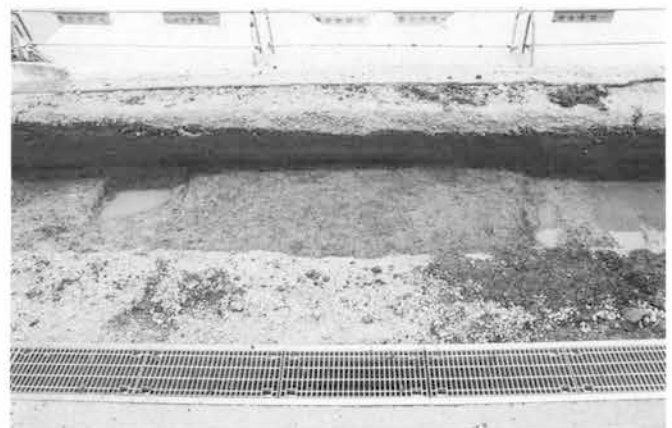
5. A区推定東山道 (東から)
