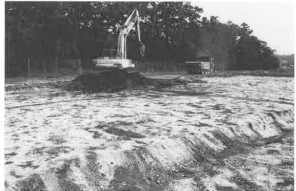
3. 重機による表土掘削作業風景（北西から）
