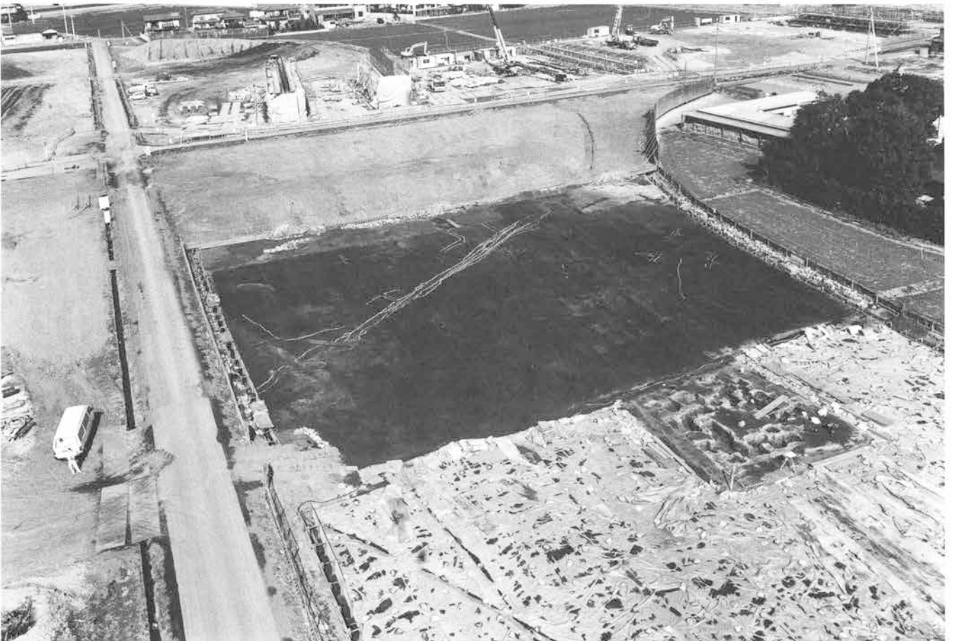
As-C混土下面E区中部全景（南上空から）
