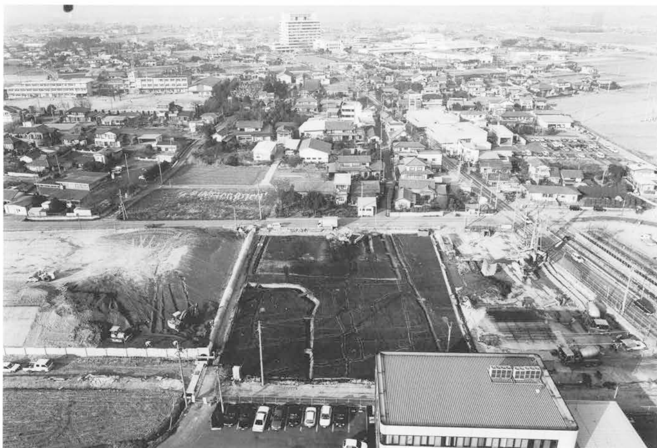
As-B下面C区西部全景（上空から）
