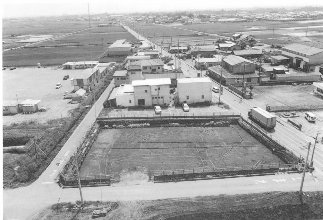
As-B下面B区全景（北上空から）
