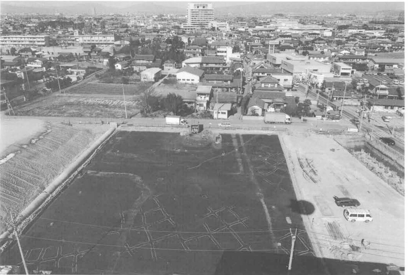
As-C混土下面C区西部全景（南上空から）
