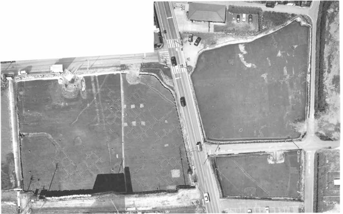
As-C混土下面全景
