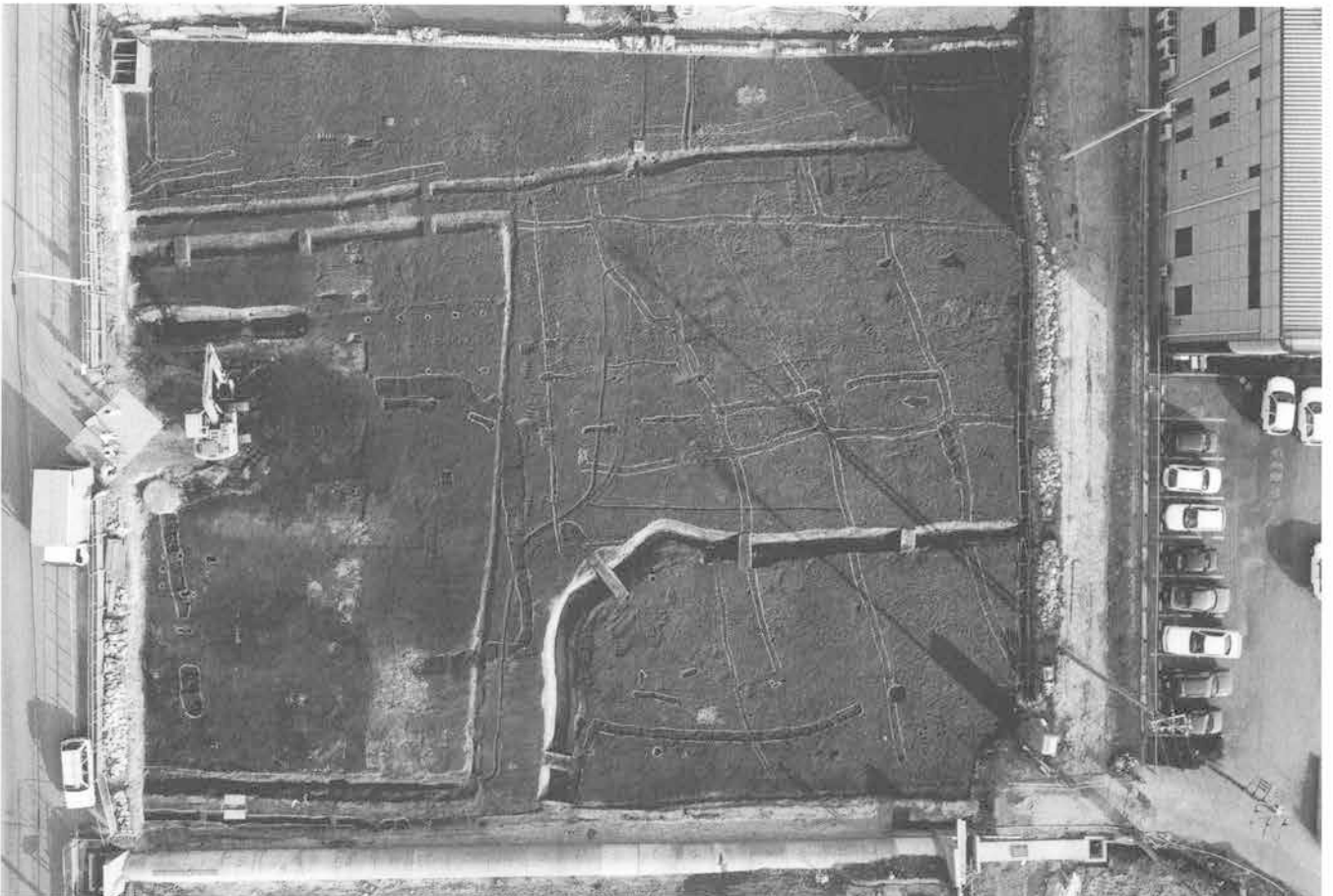
As-B下面C区西部全景（上空から）
