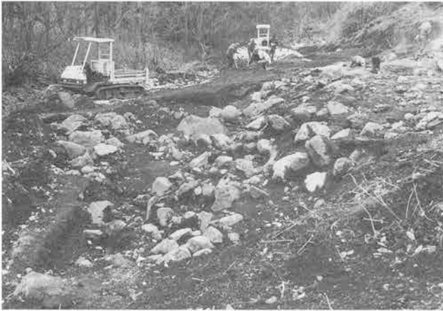
2・3区沢地旧河道部全景(北から)
