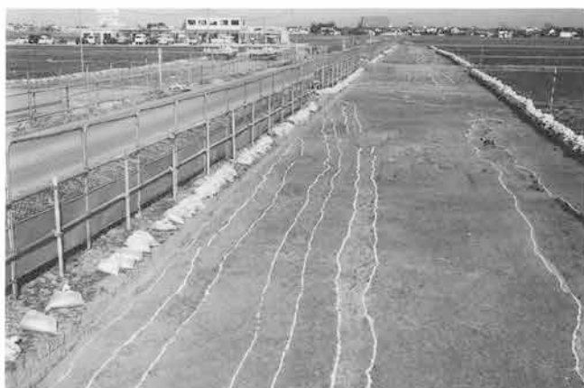
前田A区26・27・28号溝全景（南より）
