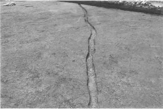
前田B区35号溝全景（北東より）
