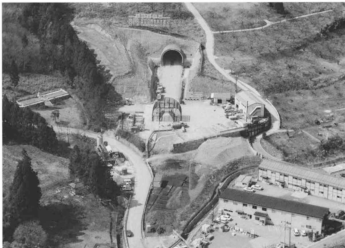
1 3区全景(里見トンネル入口付近・東から)
