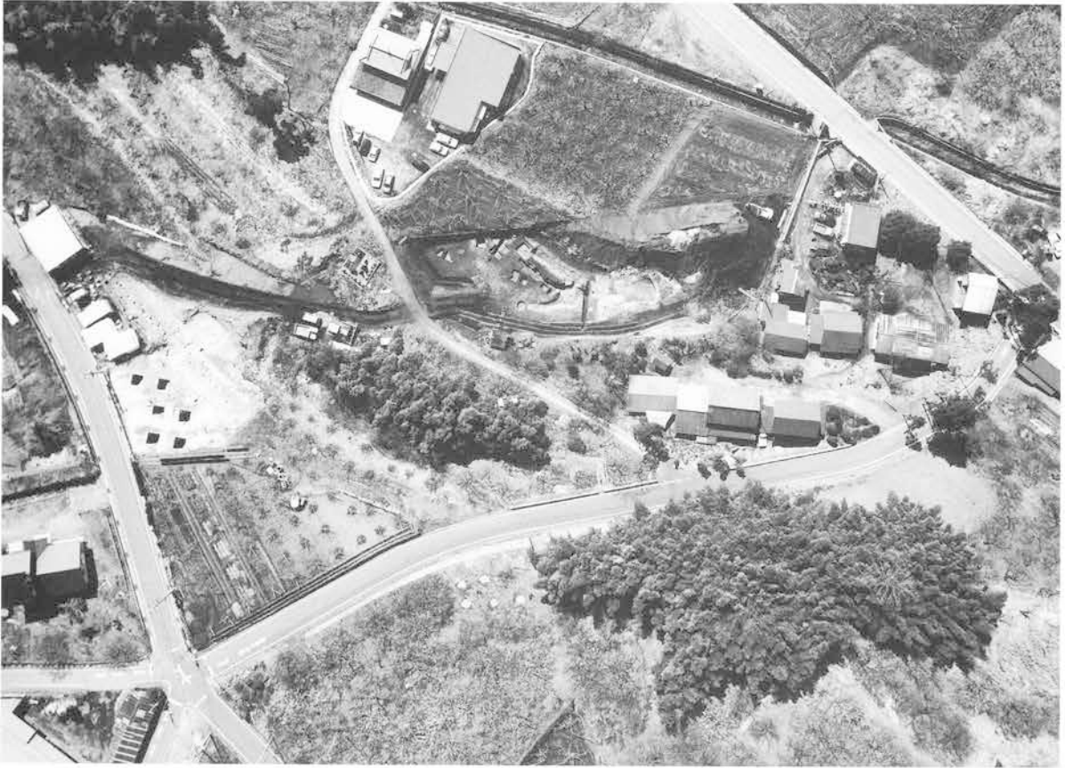
1 1区全景(左台地上は中里見原遺跡・北から)
