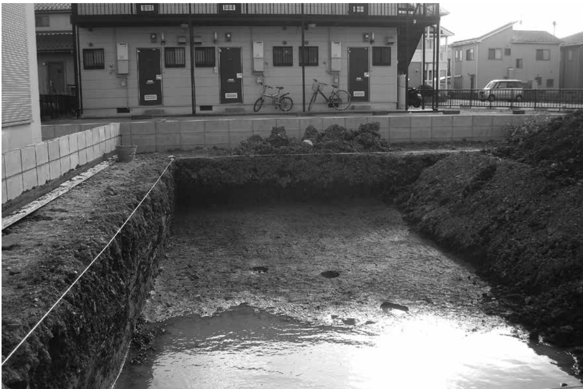
2 調査区西半部 完掘状況〔北東から〕
