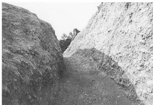
堀切頂部 (南東より)
