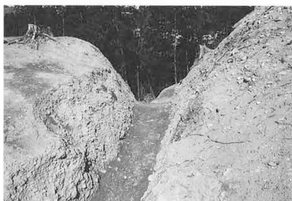
堀切頂部北寄り部分 (南東より)
