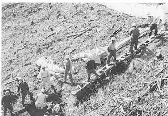
堀切南斜面掘削及び土運搬状況（北東より）
