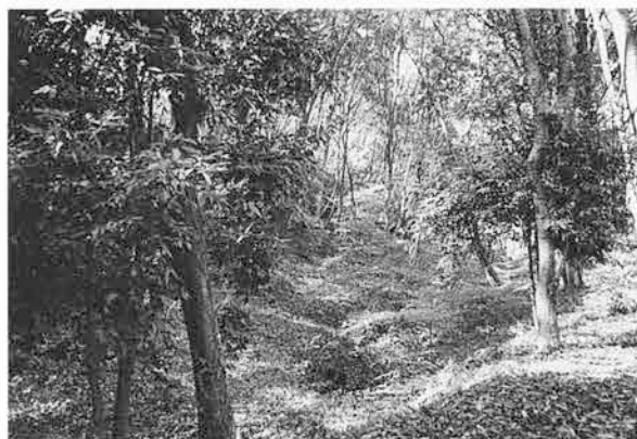
根小屋城 主郭東の横堀（南より）
