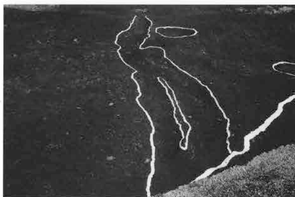
As-B下水田面水路全景 (南から)
