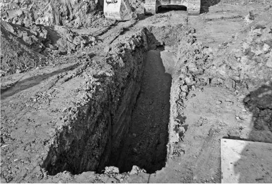
(1) C トレンチ掘削状況(北東から)
