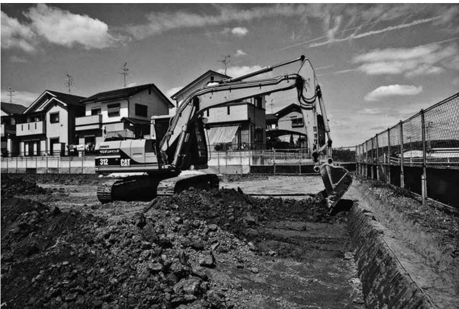
(3) A 2 地区重機掘削作業(南から)
