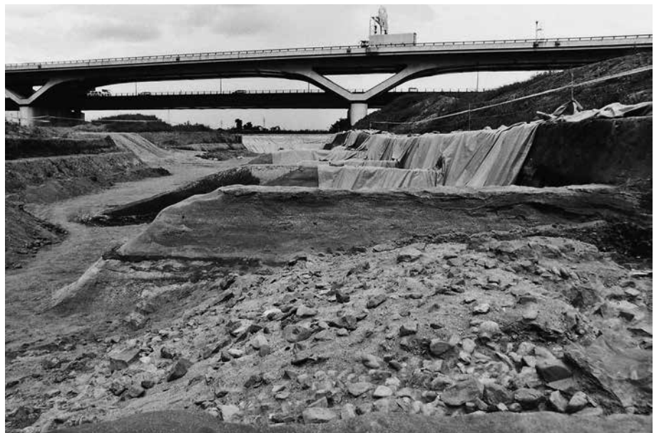
(3) C区水制 S X 6 上層断面 (南西から)
