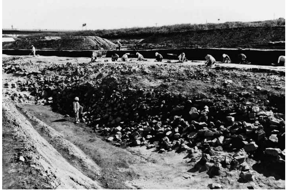
(1) E 区護岸 S X13(西から)
