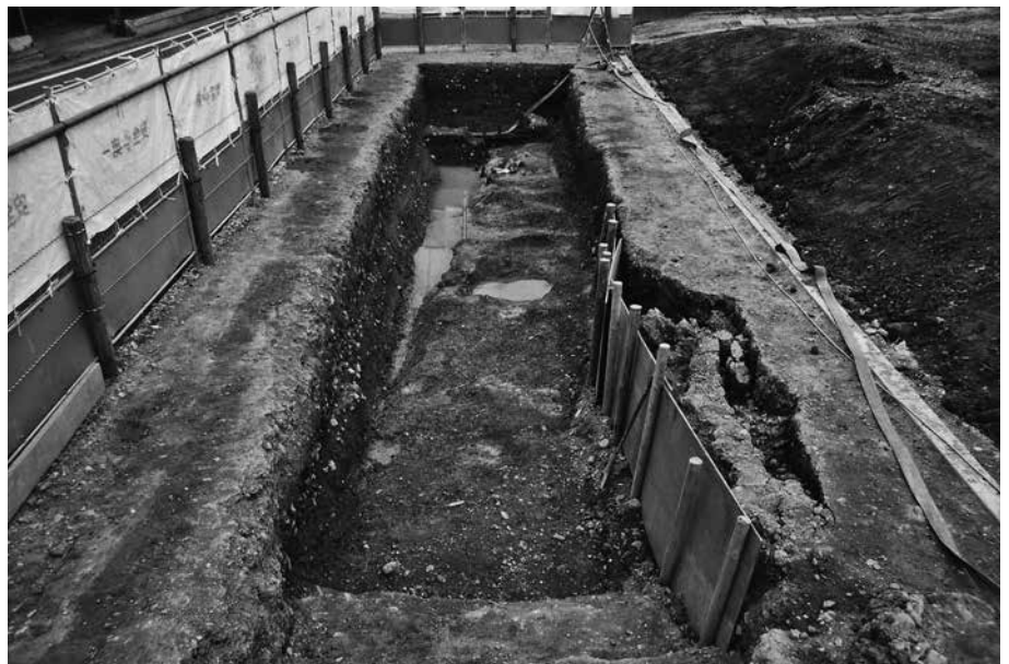
(3) トレンチ東半部 堆積土除去後全景 (西から)
