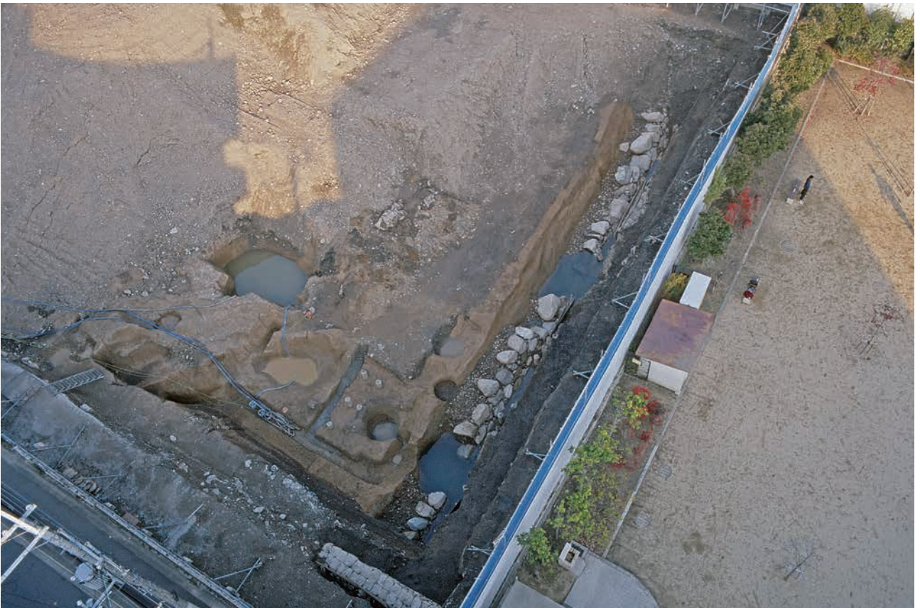
(2) 石垣S W105検出状況(南西から)
