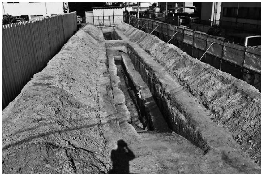
(3) 第 1 ・ 2 トレンチ全景(西から)
