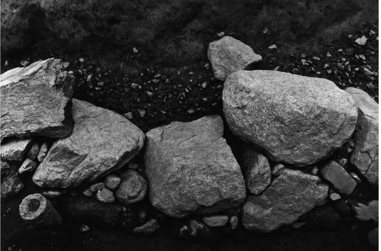
(1) 石垣 S W105 B・C地区検出状況(南から)
