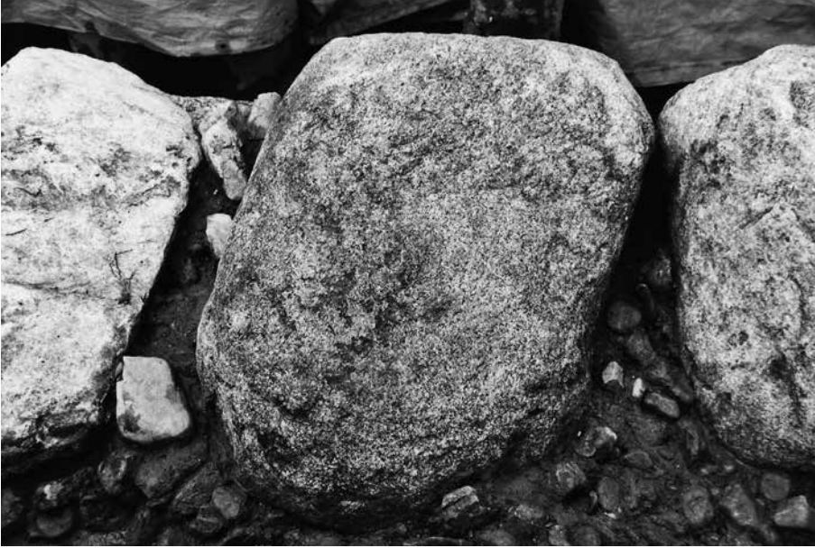
(1)石垣 S W105 石材 f 1 検出状況(北から)
