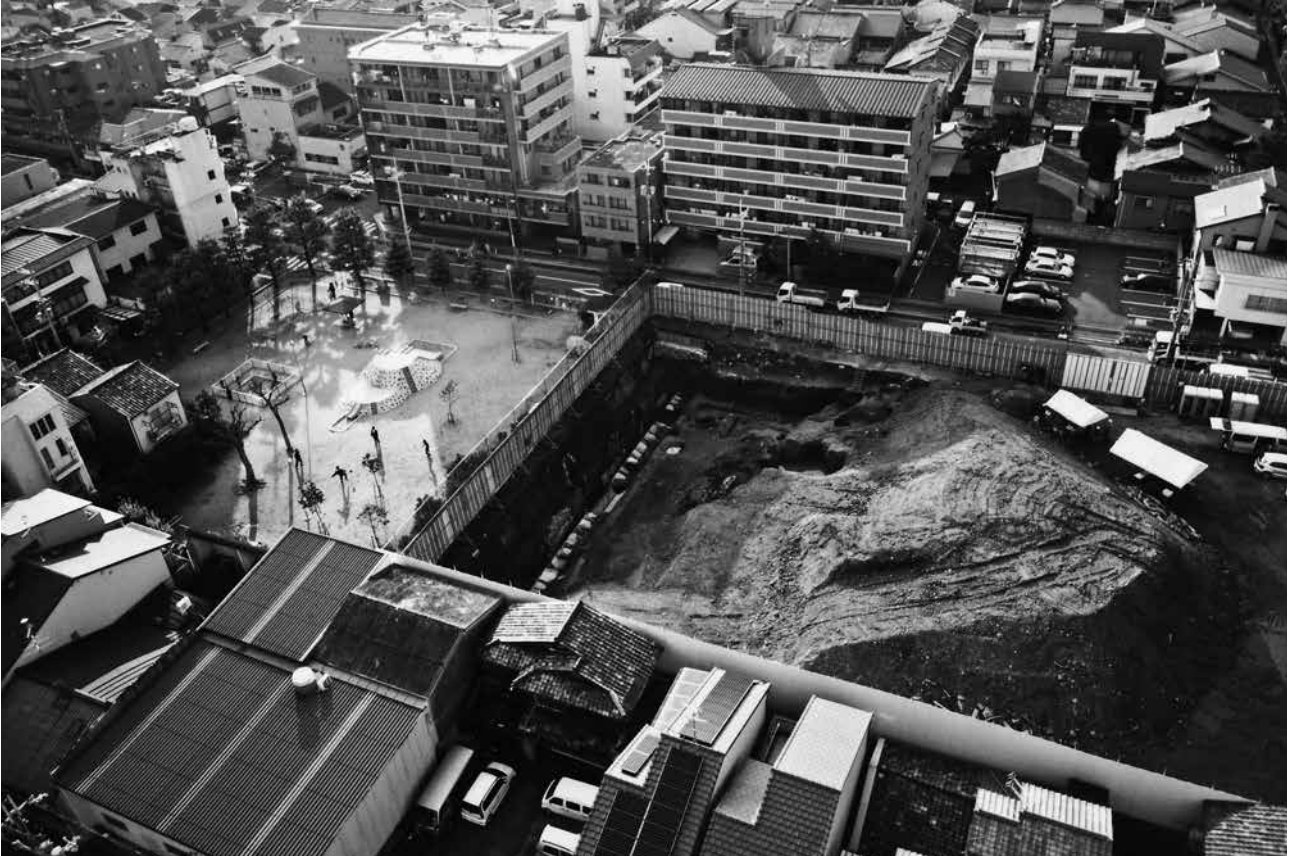
(1) 石垣 S W105 検出状況 (北東から)
