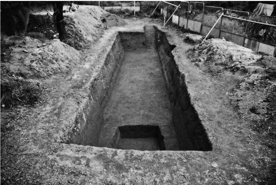
(2) 第6トレンチ全景(西から)
