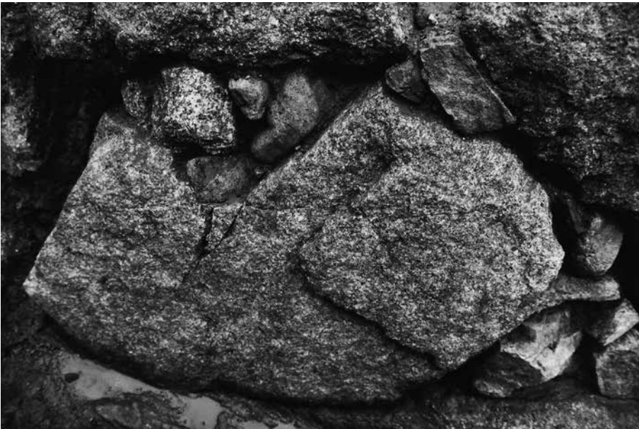
(2)石垣 S W105 石材 h 6 検出状況(南から)
