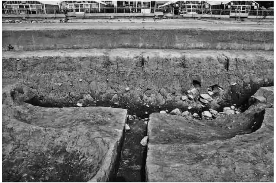
(1) 7区土坑S K7177北壁断面 (南から)
