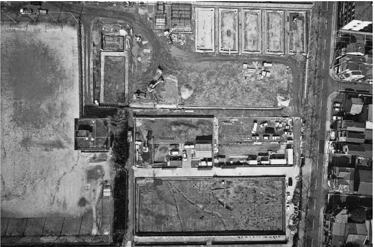
(2) 2区全景(空中写真 上が北)
