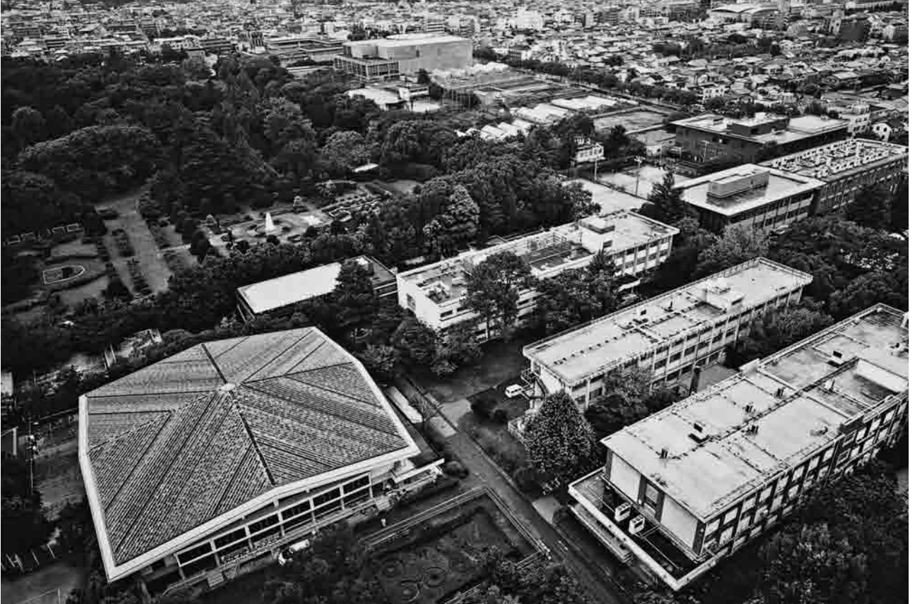
(1) 9区遠景(空中写真 南西から)
