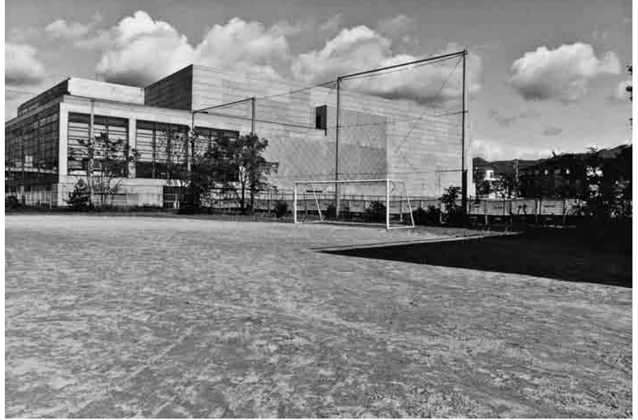
(1) 1区調査前状況(南西から)
