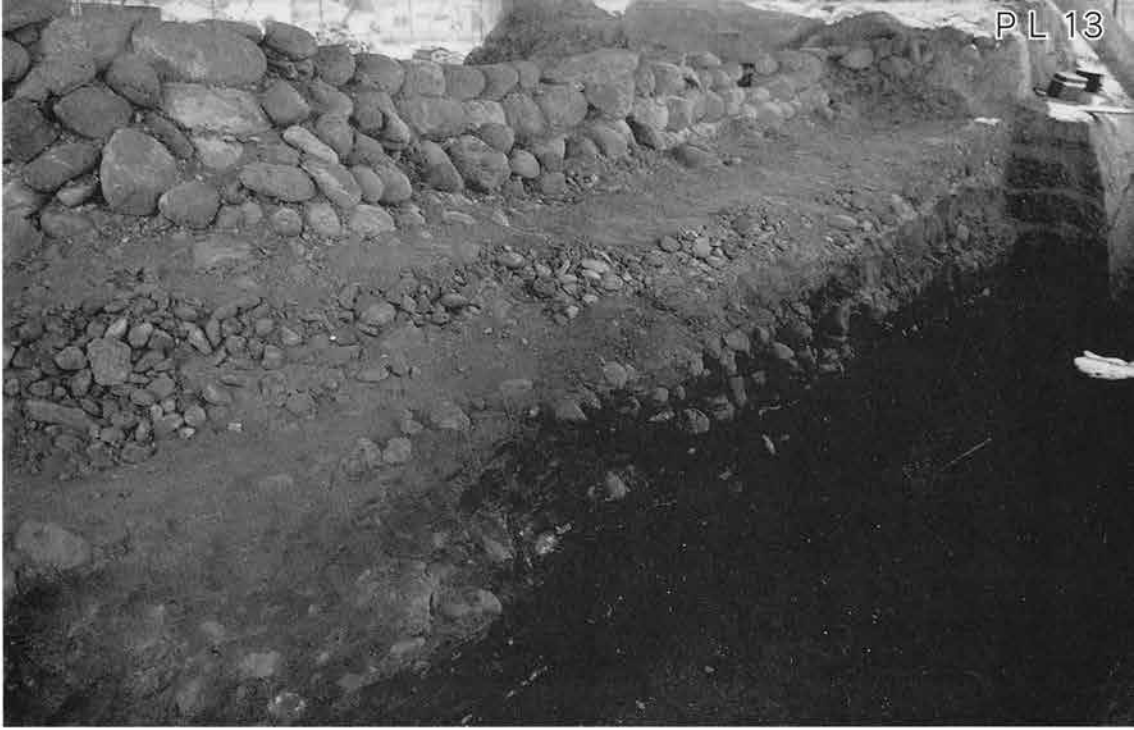
1. 左壁裏込 (奥から)
