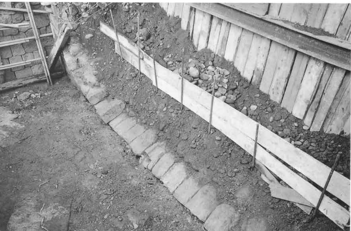
3. 玄室右壁の残存状況
