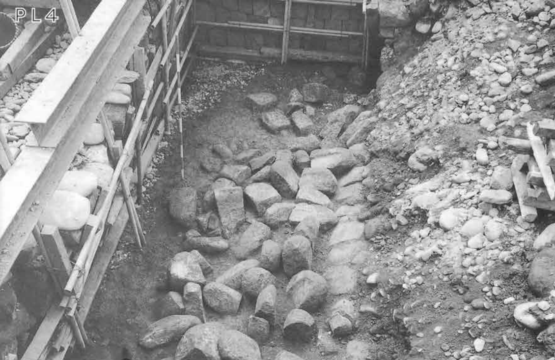
1. 玄室右壁崩壊状況
