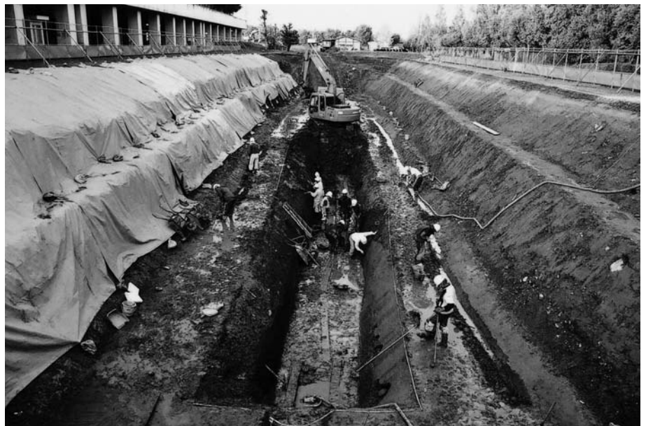
(3) 2 トレンチ作業状況(南から)
