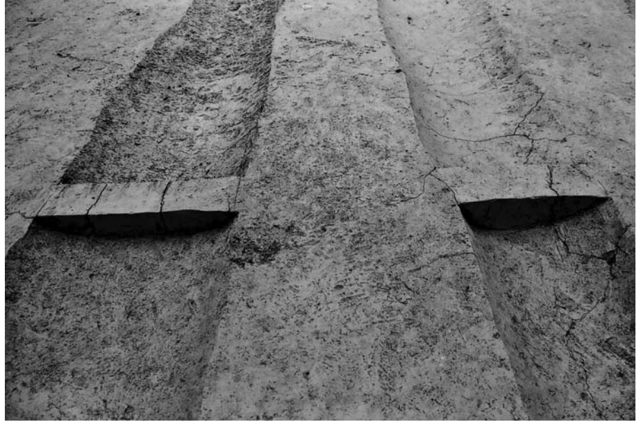
(1) 1 トレンチ溝状痕跡 7・8 アゼ断面(南から)
