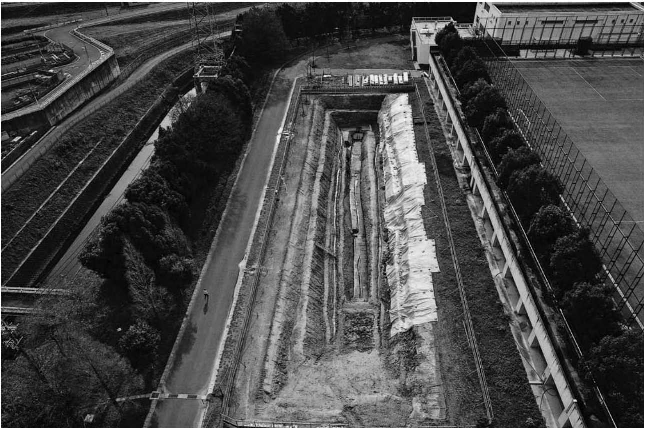
(2) 2 トレンチ全景 (空撮、北から)
