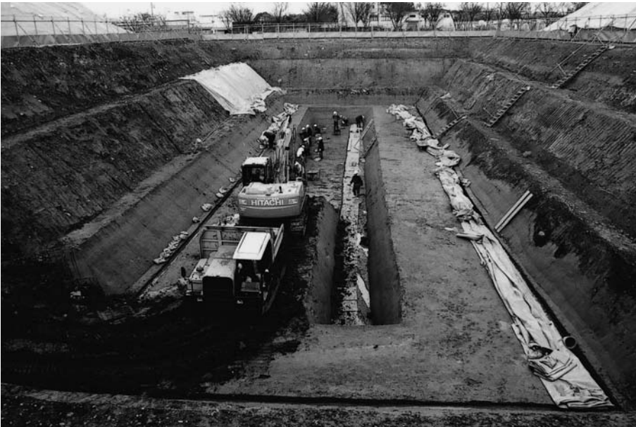
(2) 1 トレンチ作業状況(南から)
