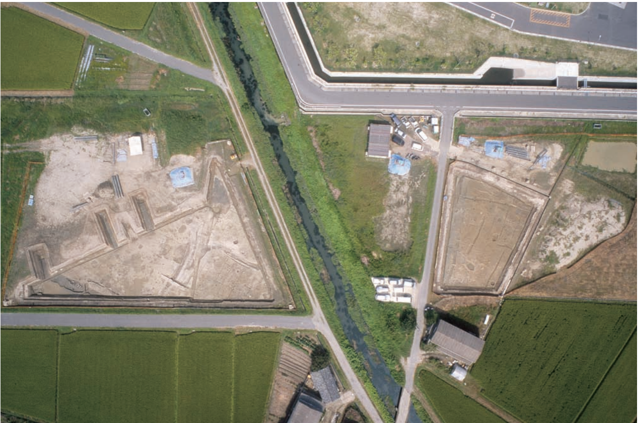
(2) Ⅲ区4トレンチ・Ⅳ区1～3トレンチ全景(上が北)
