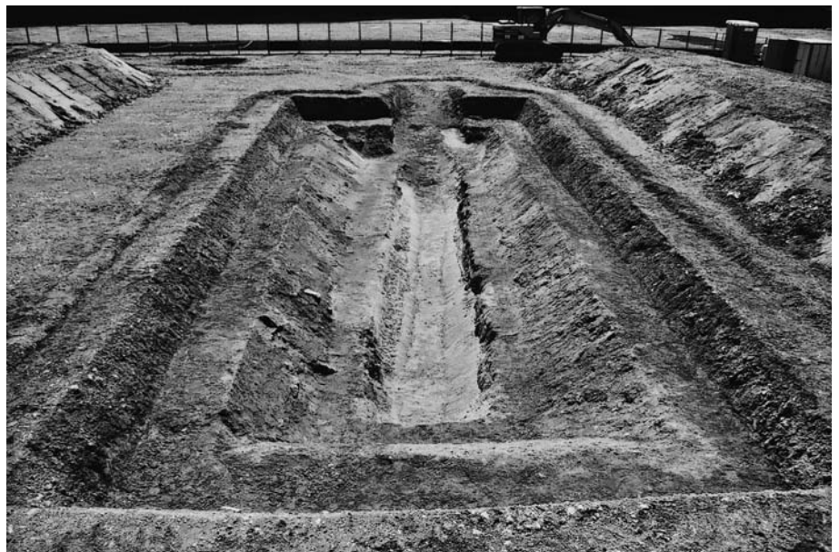
(3) V区1 トレンチ全景(北から)
