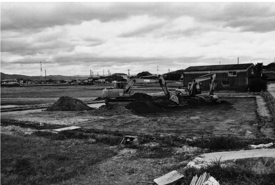
(3) Ⅲ区 4 トレンチ重機掘削 (北西から)
