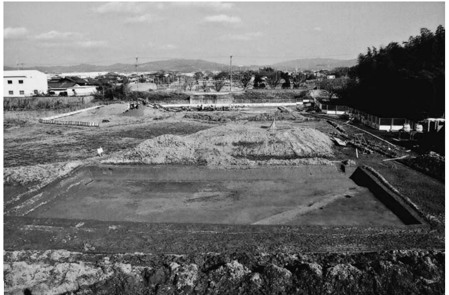
(2) 6 トレンチ全景(西から)
