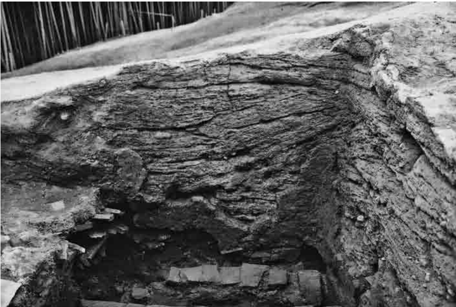
(2) 2 a号窯焼成室側壁(北から)
