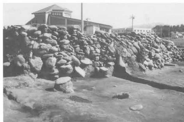
4 西奥側裏込め
