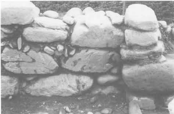
6 東側玄門および玄室側壁
