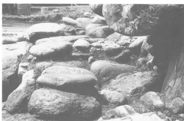
2 東側裏込め下
