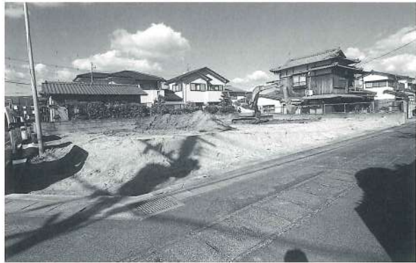
PL. 29 調査地近景 (南西から)
