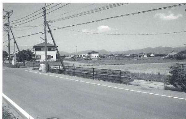
PL.6 調査地近景 (南西から)
