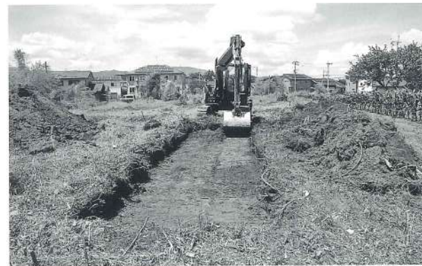
PL. 18 No.2試掘溝 機械掘削状況
