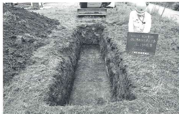
PL.10 No.1試掘溝 (西から)
