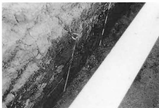
3区東側溝 立ち合い調査 (北西から)
