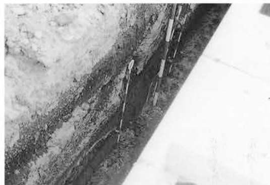
3区東側溝 立ち合い調査 (北西から)
