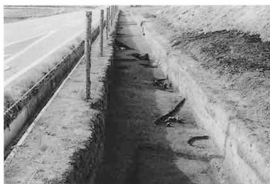
3区南側 調査状況 (東から)
