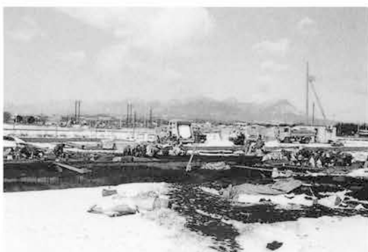
作業風景 (東から)
