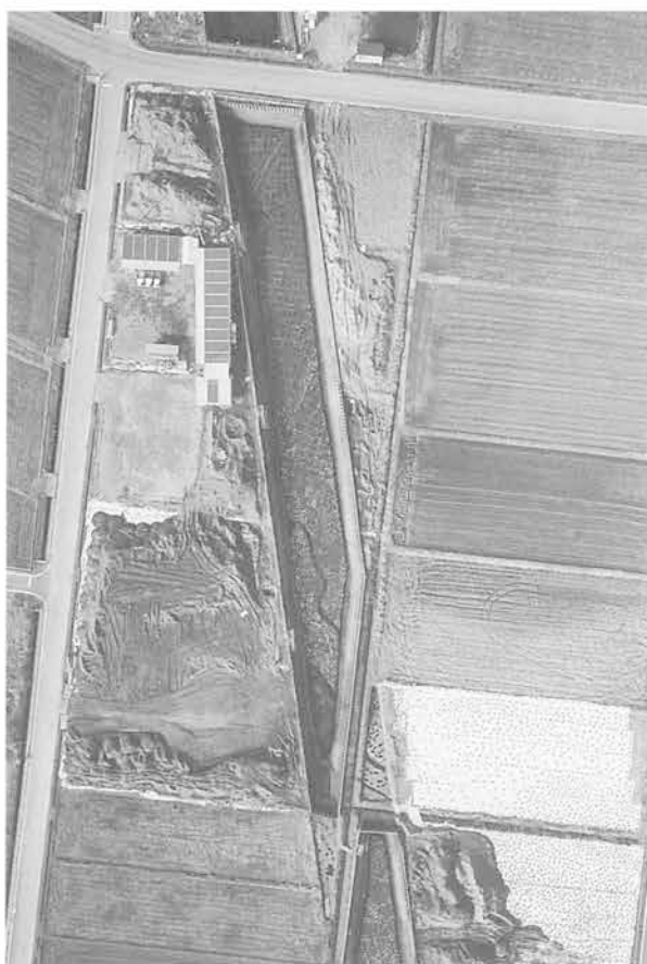
浜川高田 Hr-FA下水田 27～38区 全景 (南東)
