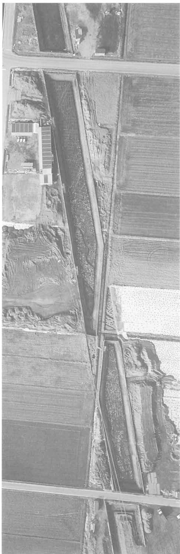
浜川高田 Hr-FA下水田 16～38区 全景 (南東)
