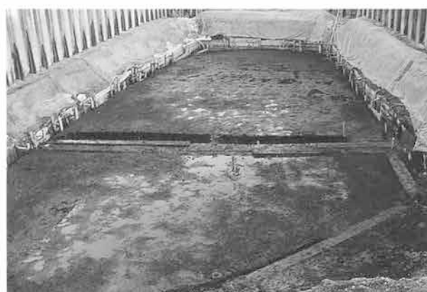
浜川館 As-C下水路南側
