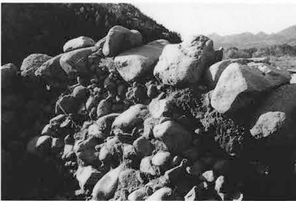
玄室西側壁相当部分の石積み
