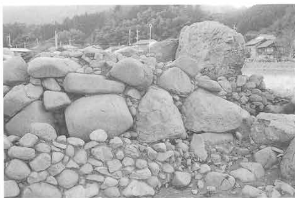
玄室東壁崩落状態
