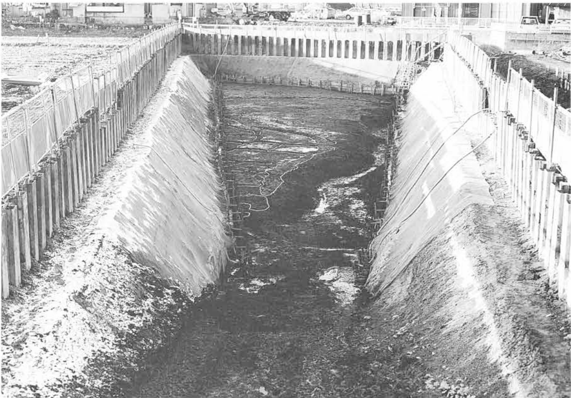
No 5 エリアAs-C下水田・3号溝全景 (南東より)
