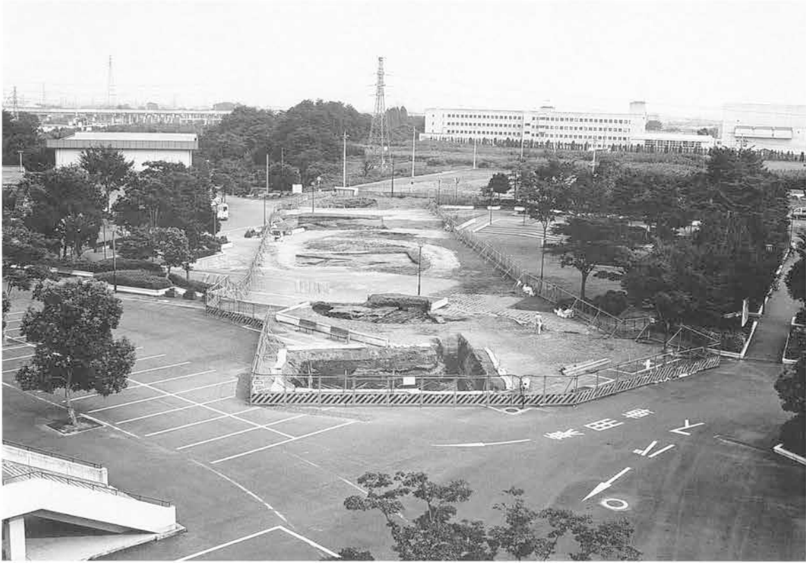
No 1～No 5エリア全景（北西より）
