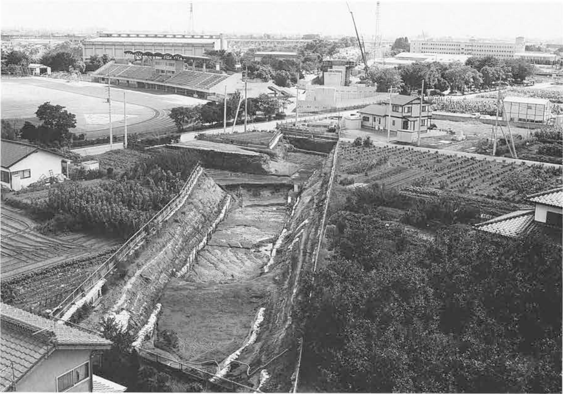
No 7 エリアHr-FA下面全景（北西より）
