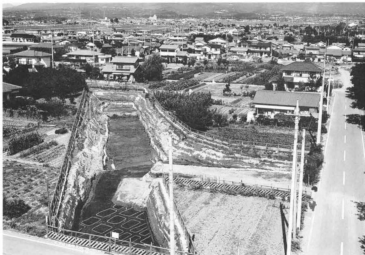
No 7 エリアHr-FA下面全景（南東より）
