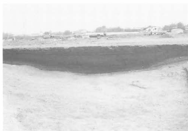
22号溝完掘状態（北より）
