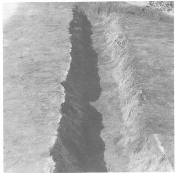
10号道路 掘り上がり (東から)
