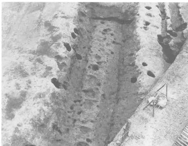
24(右)・25(左)号溝 掘り上がり (西から)
