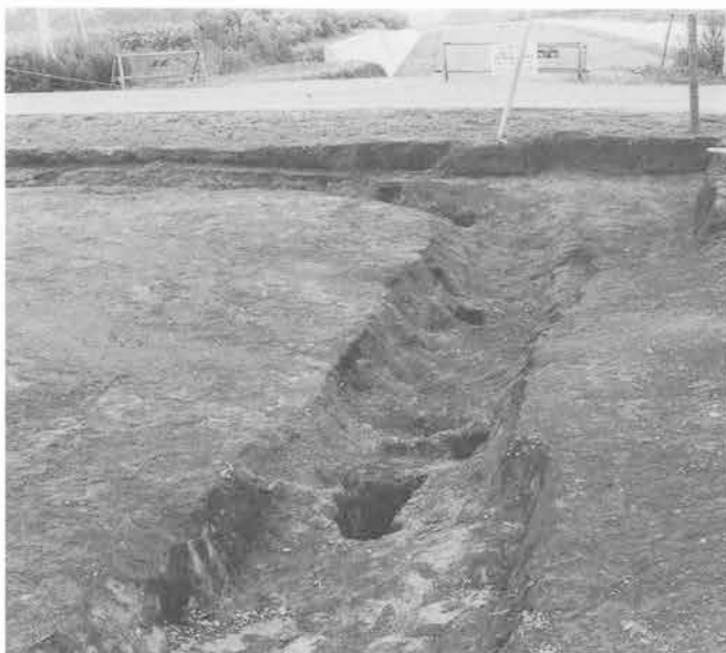
05号道路 掘り上がり (南から)
