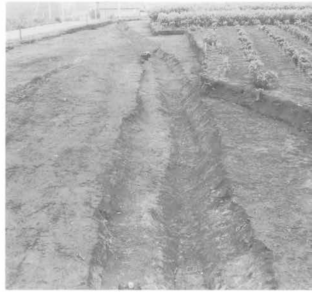
05号道路 掘り上がり (西から)
