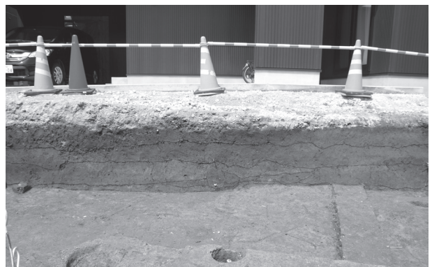
4. 321次 西壁壁面（東から）
