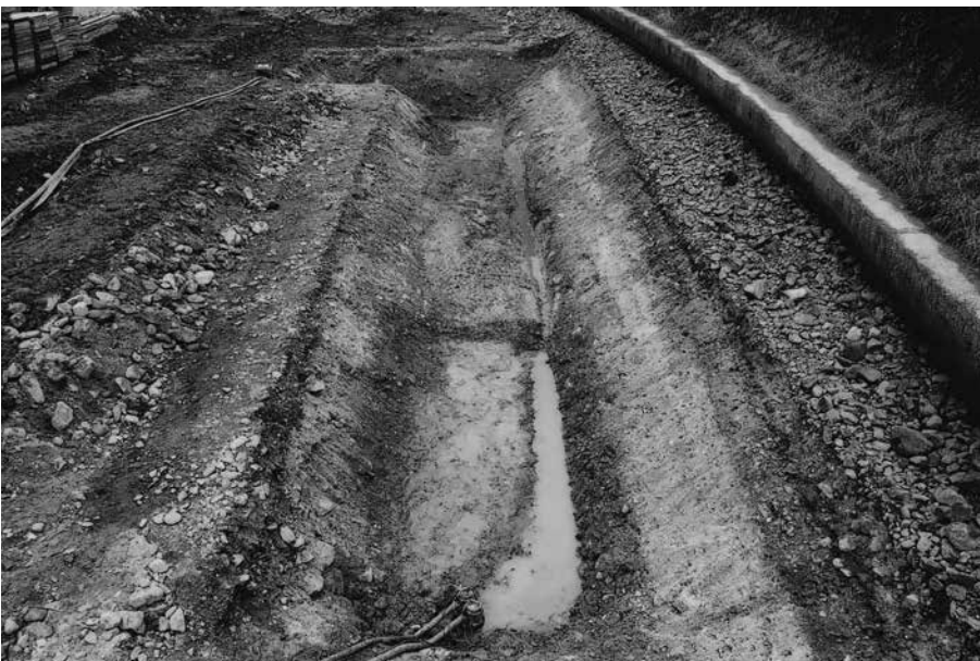
(3)24-2 トレンチ完掘後全景 (北西から)
