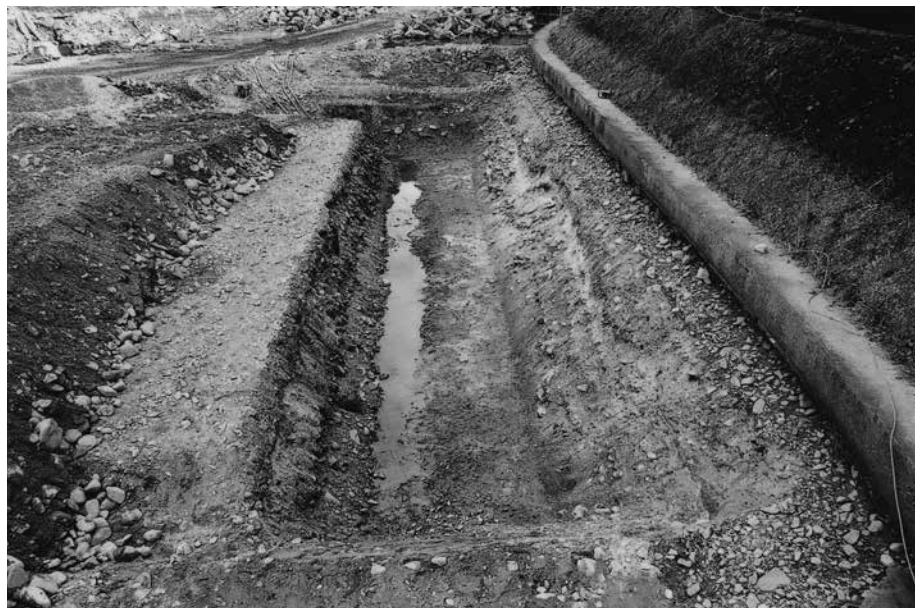
(3)24-3 トレンチ完掘後全景 (北西から)
