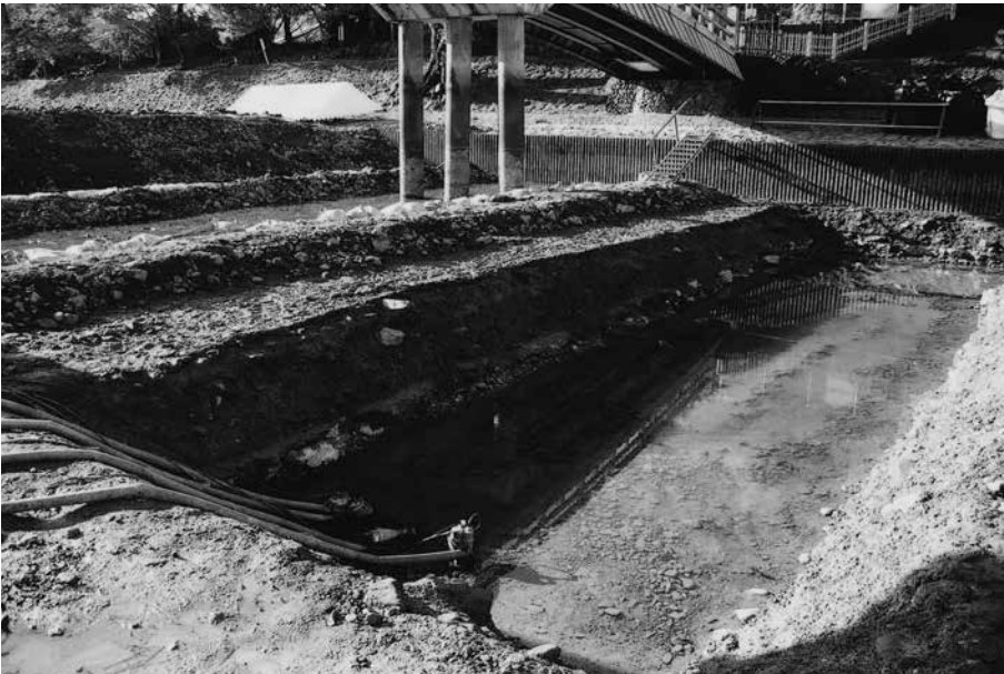
(2)24-1 トレンチ断面(北から)
