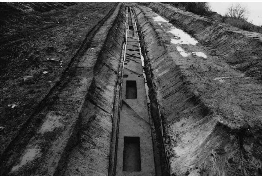
(3) 第 2 トレンチ近景(南東から)
