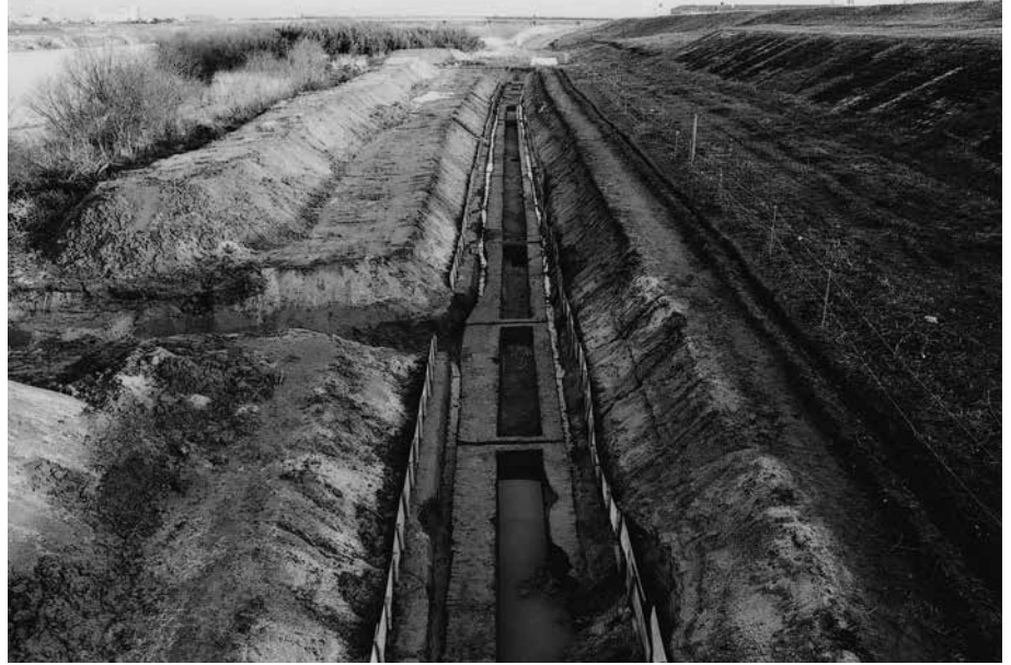
(1) 第 2 トレンチ全景(北西から)
