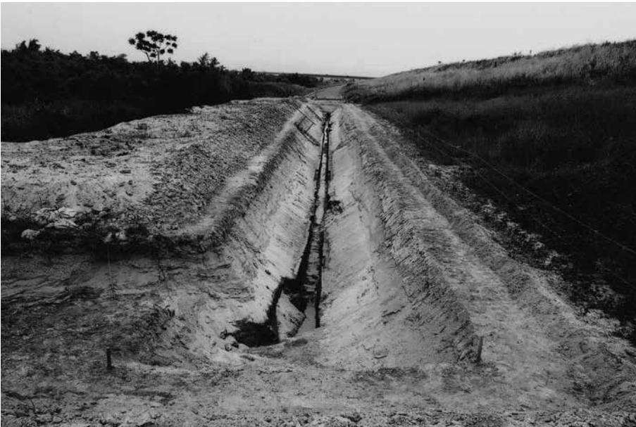
(2) 第 1 トレンチ全景(北西から)
