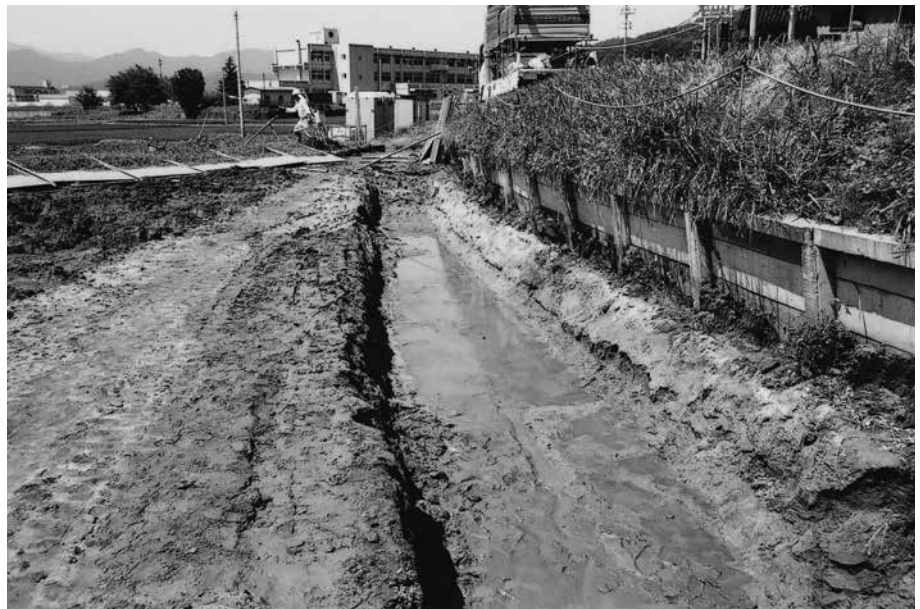
(2) トレンチ掘削状況(北東から)
