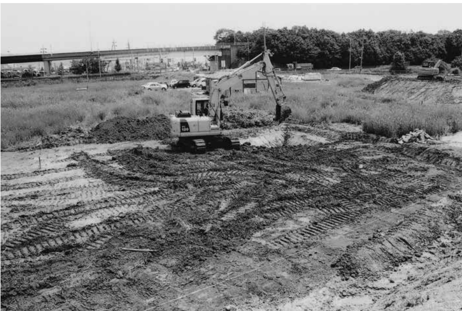
(3) E 5 区重機掘削(北西から)
