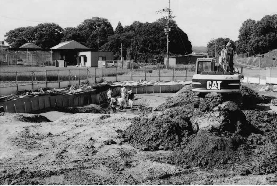
(1) B 2 区重機掘削(北から)
