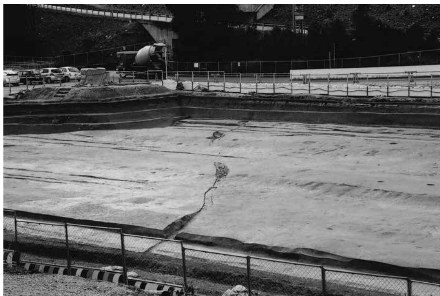
(2) A 3区溝 S D24全景(北東から)
