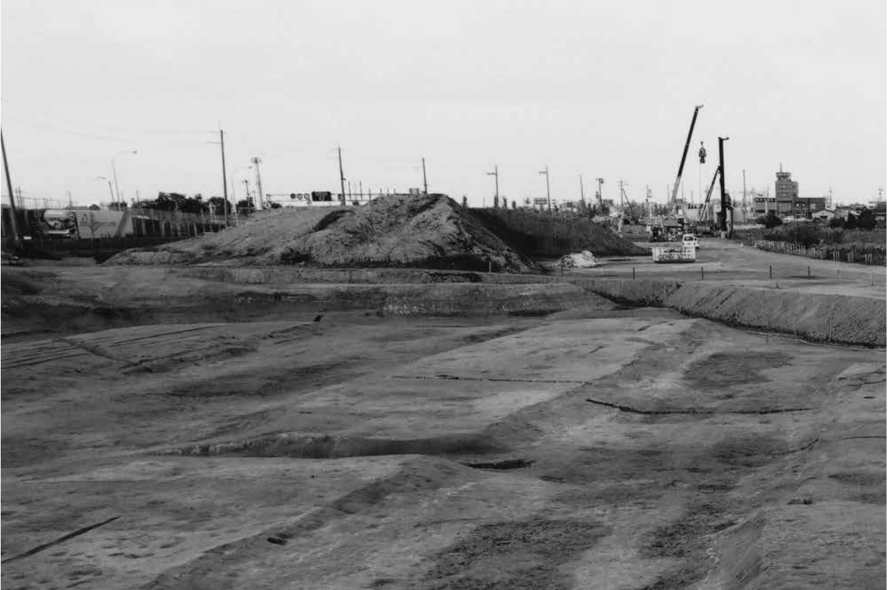
(1) C 2 区島畑21全景(南東から)
