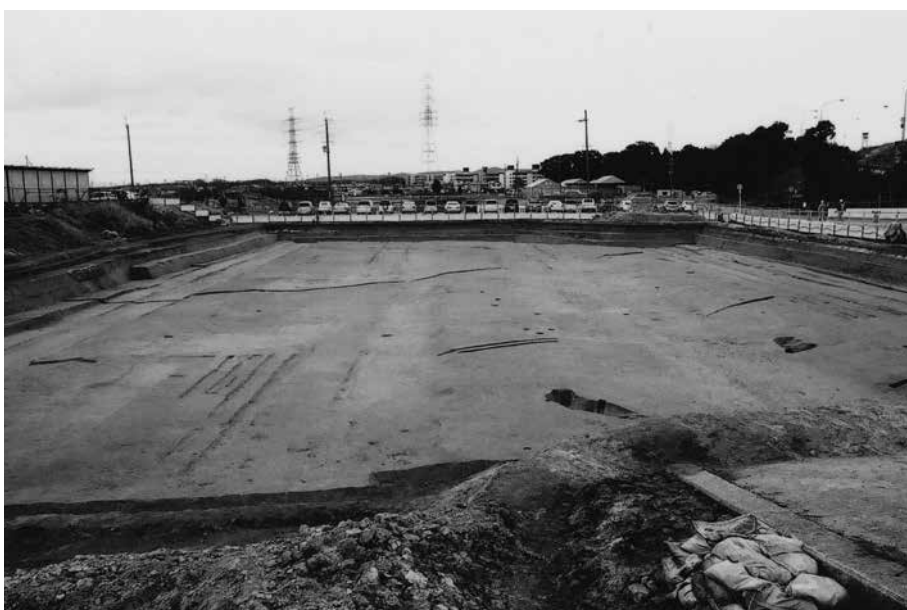
(3) A3区下層遺構面全景(南から)
