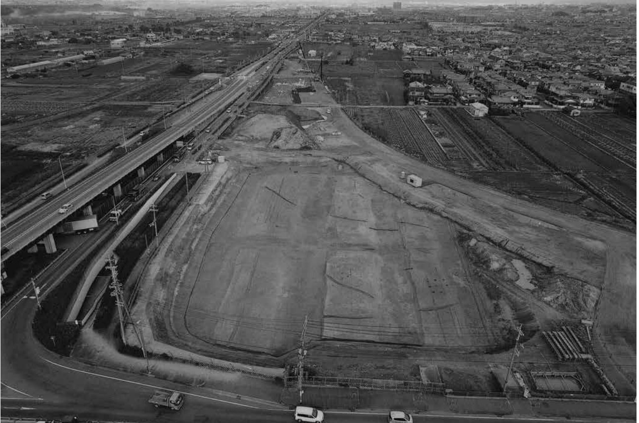
(1) C 2 区全景 (南から)
