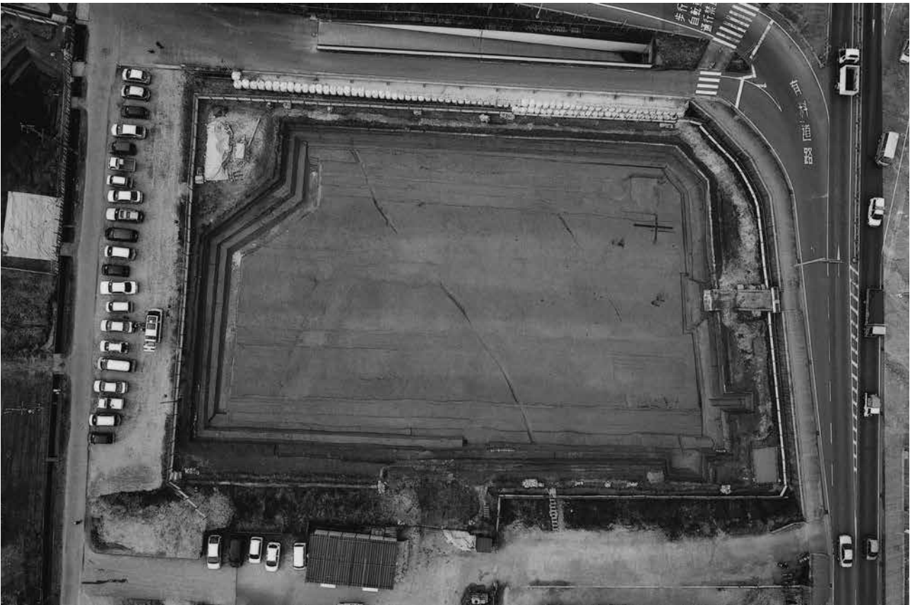
(2) A3区全景(上が西)
