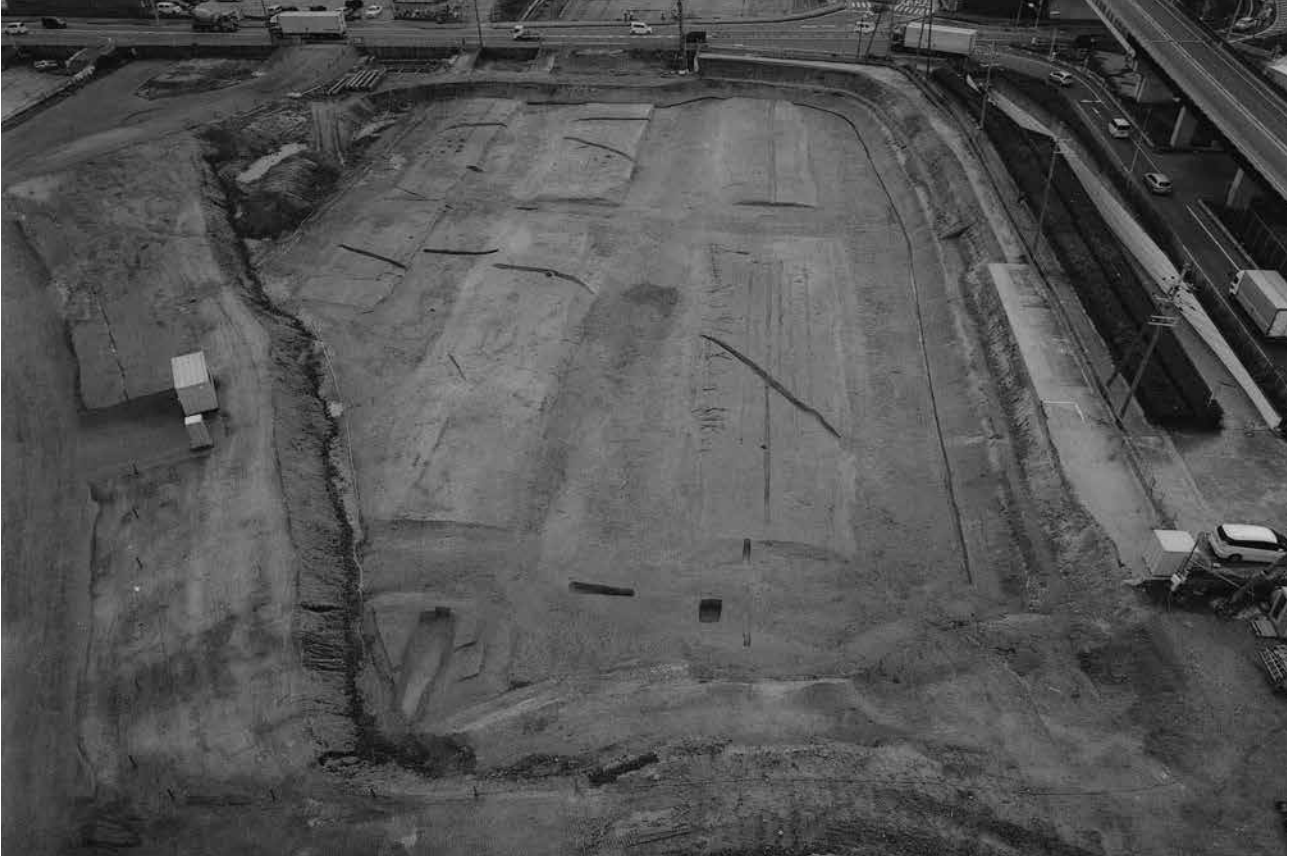
(1) C 2 区全景(北から)
