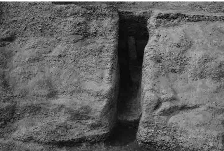
(3) 49号横穴完掘状況(南東から)
