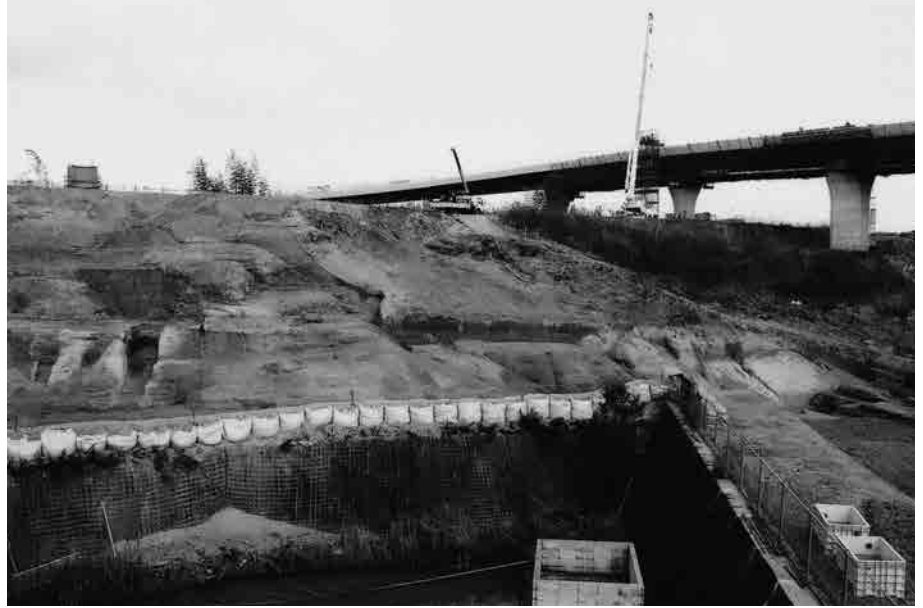
(1) 6 トレンチ遠景(南から)
