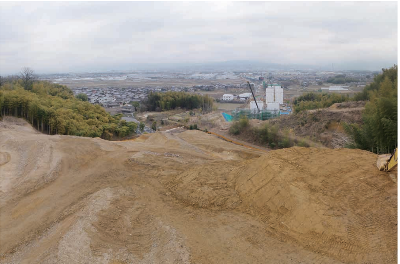
(2) 4トレンチからの木津川方面への眺望(西から、合成写真)
