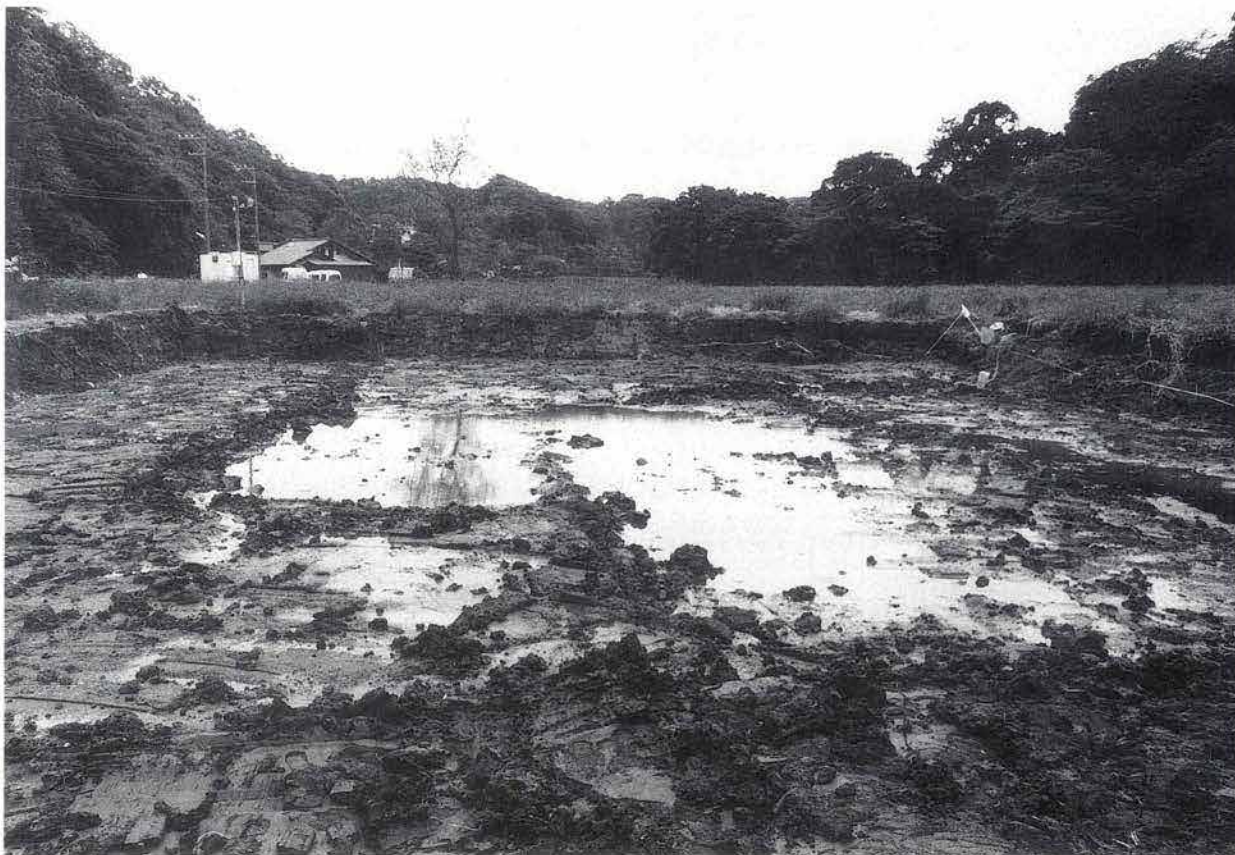
▲1. 重機による掘削終了直後
