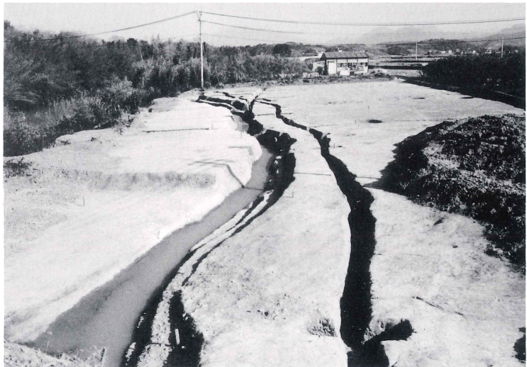
K~S区 全景 (北方向から)
