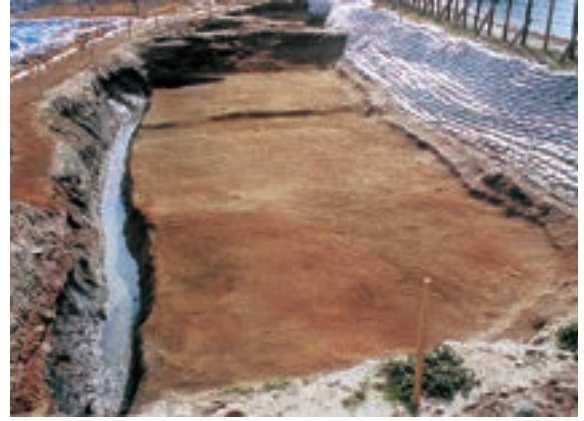
17-1区完掘状況（北から）
