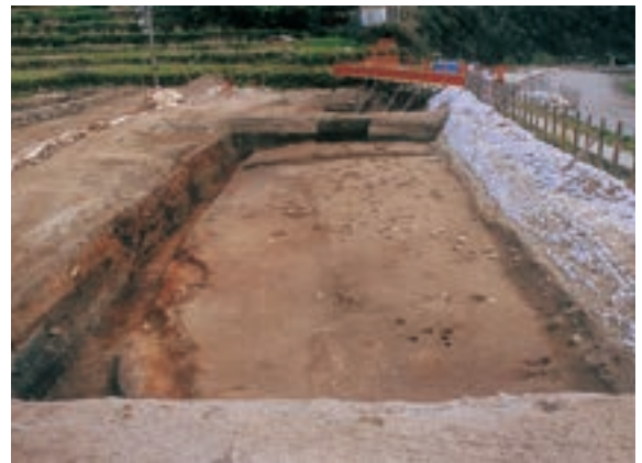
17・18-4区完掘状況（北から）
