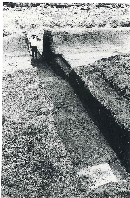
河内谷馬場跡第4トレンチ断ち割り状況
