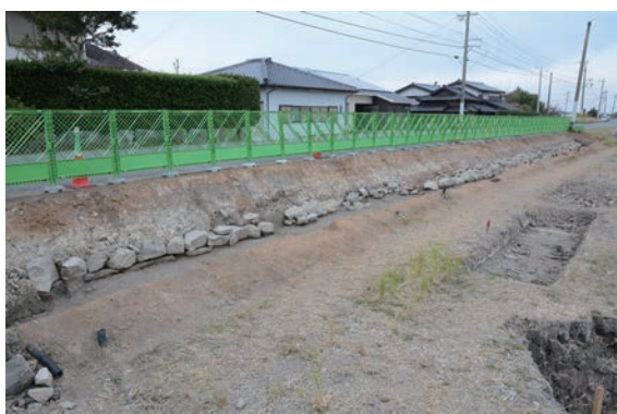
5. D①区完掘(南西から)
