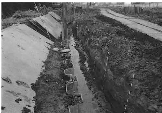
2 同1 排水溝断面
