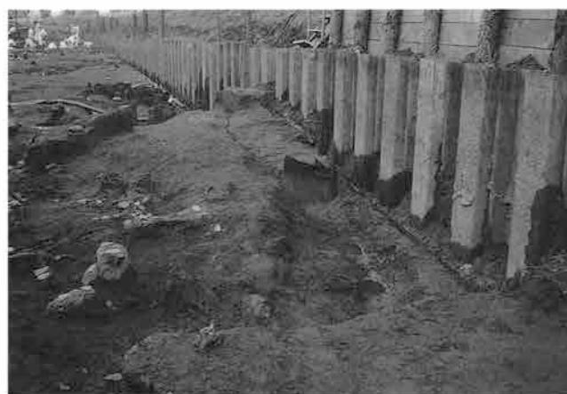
5 同1 1号河道(南から)
