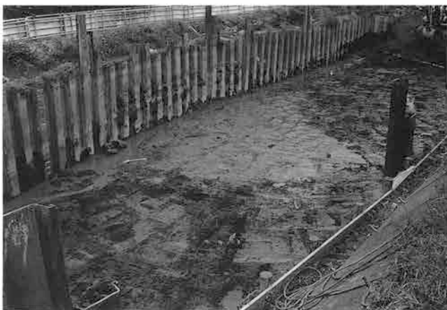
3 VI区低地 X層面、白い部分が台地部
