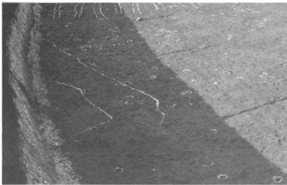
写真67 15号蛙状遺構 (南東から)
