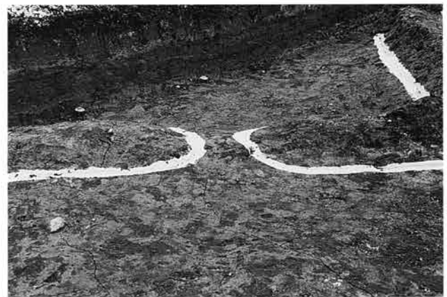
1区東 水田水口
