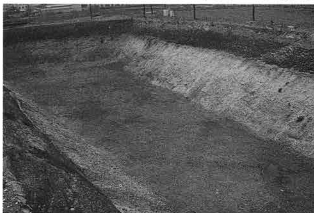
1区西 遺構確認状況
