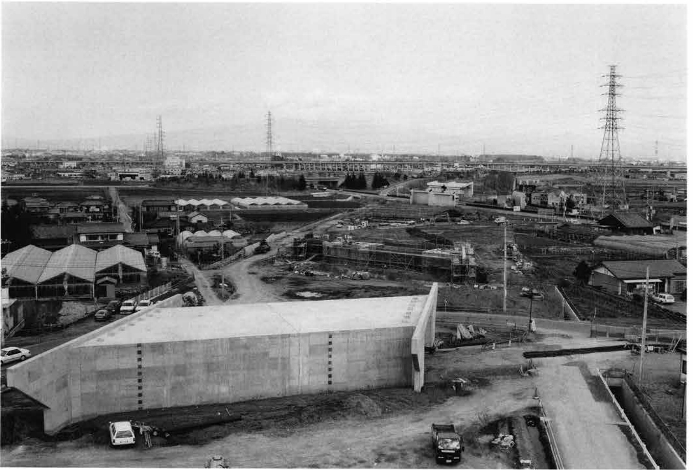
A・B区全景（南から）
