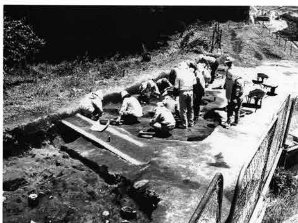
町道拡幅 北側発掘作業風景
