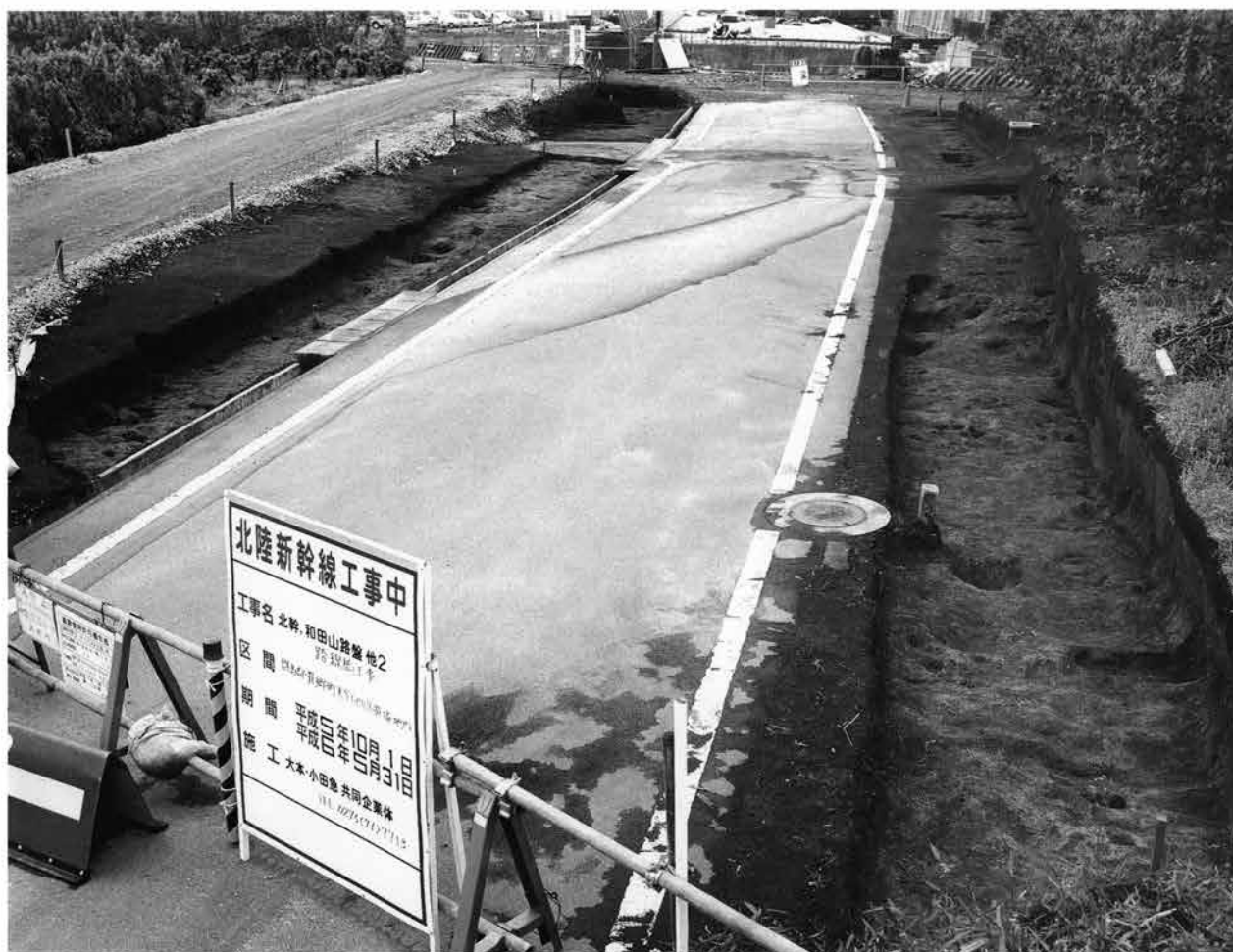
町道拡幅 1-149 拡幅部分全景
