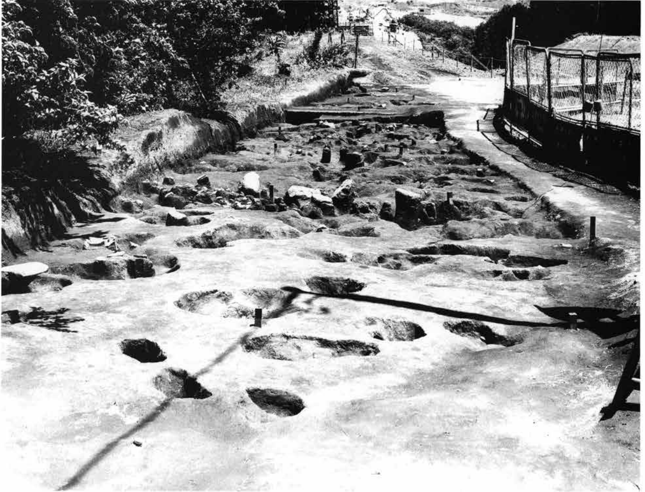
町道拡幅 北側部分全景
