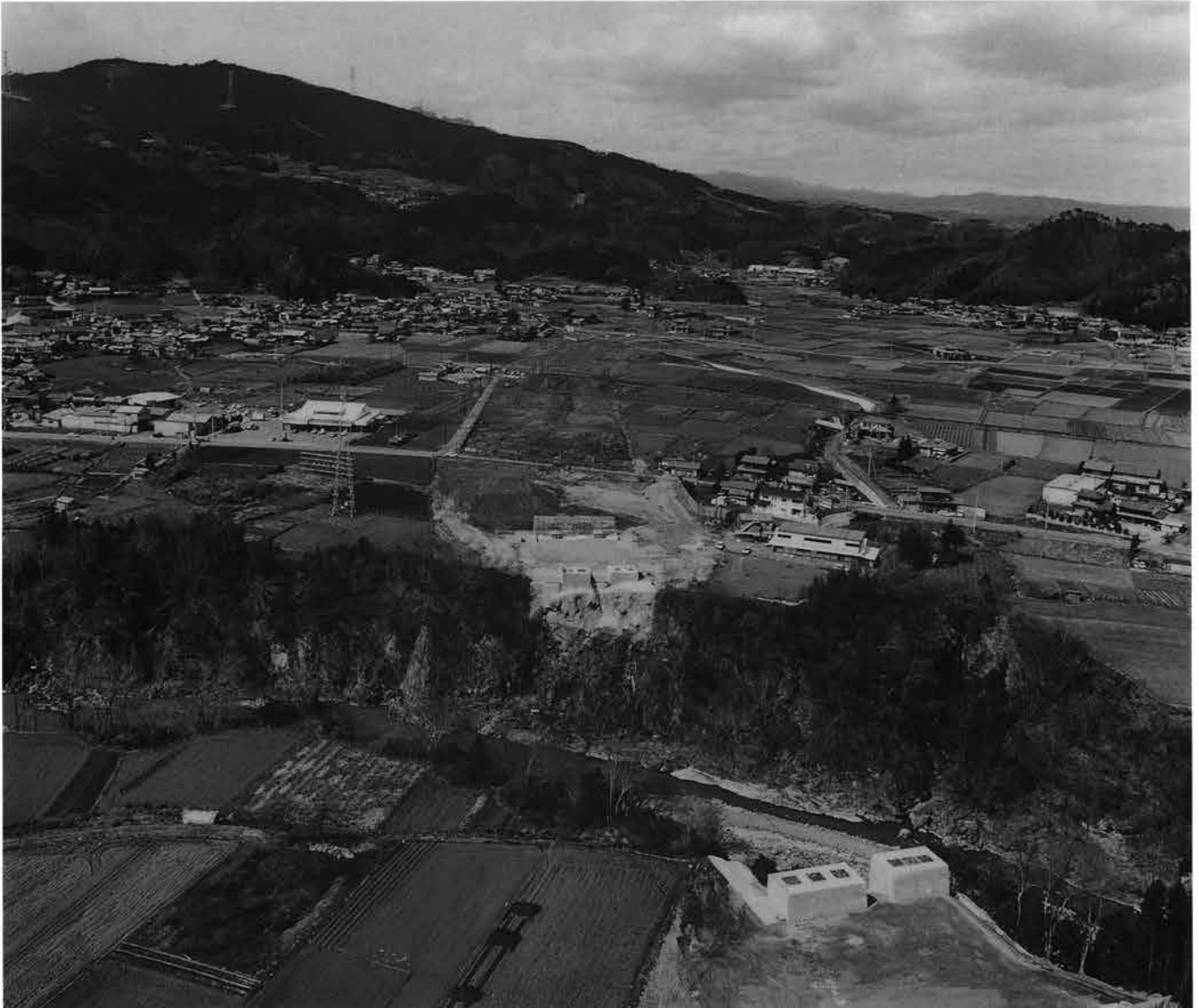
調査区遠景（南より）
