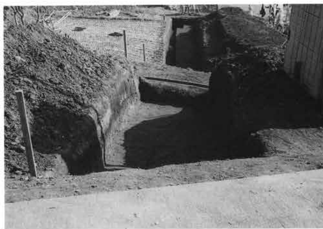
3 北トレンチ全景 (西から)
