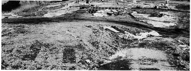
保存部分の埋め戻し
