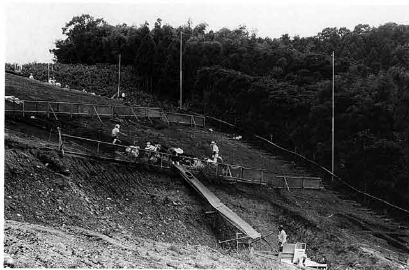
落下方式での排土 (上) (下) ポールは落雷避難施設 (上)
