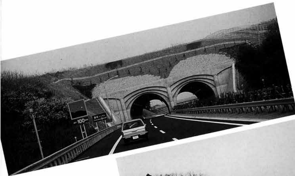
「富岡トンネル」と保存部分 （観音山尾根中央）
