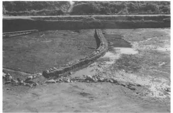
5号暗渠 全景（北から）
