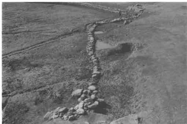
6号暗渠 全景 (東から)
