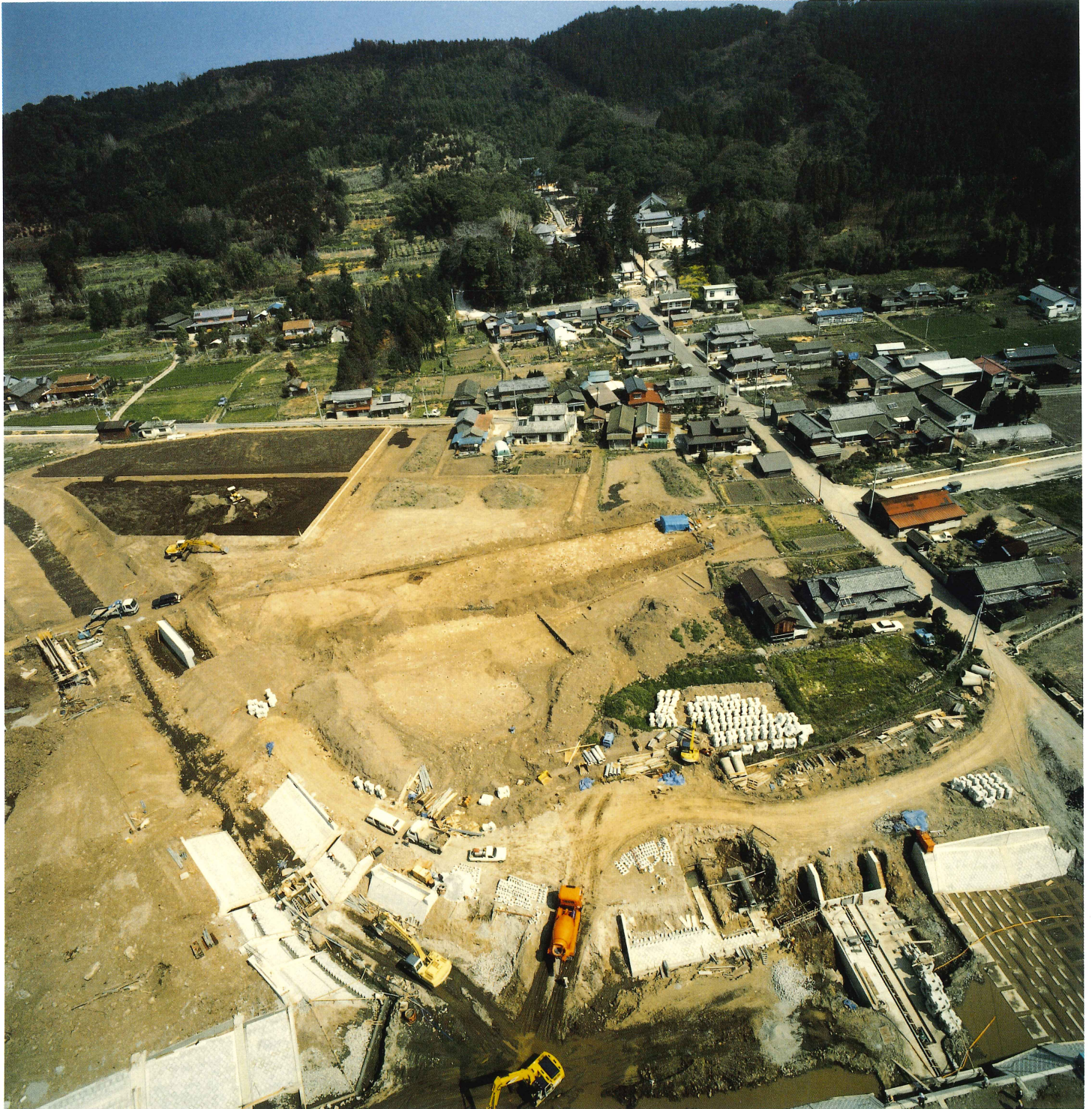
29. 陽弓遺跡全景（南から北方を見る） 上方名利泉福寺、道路予定地部分が県教委発掘区。遺跡の西地区はすでに河川改修・ 道路工事中。手前が町教委発掘区
