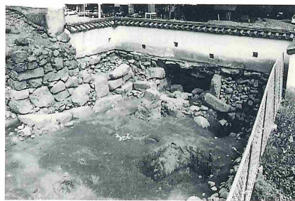
西の丸廊下橋入口周辺状況
