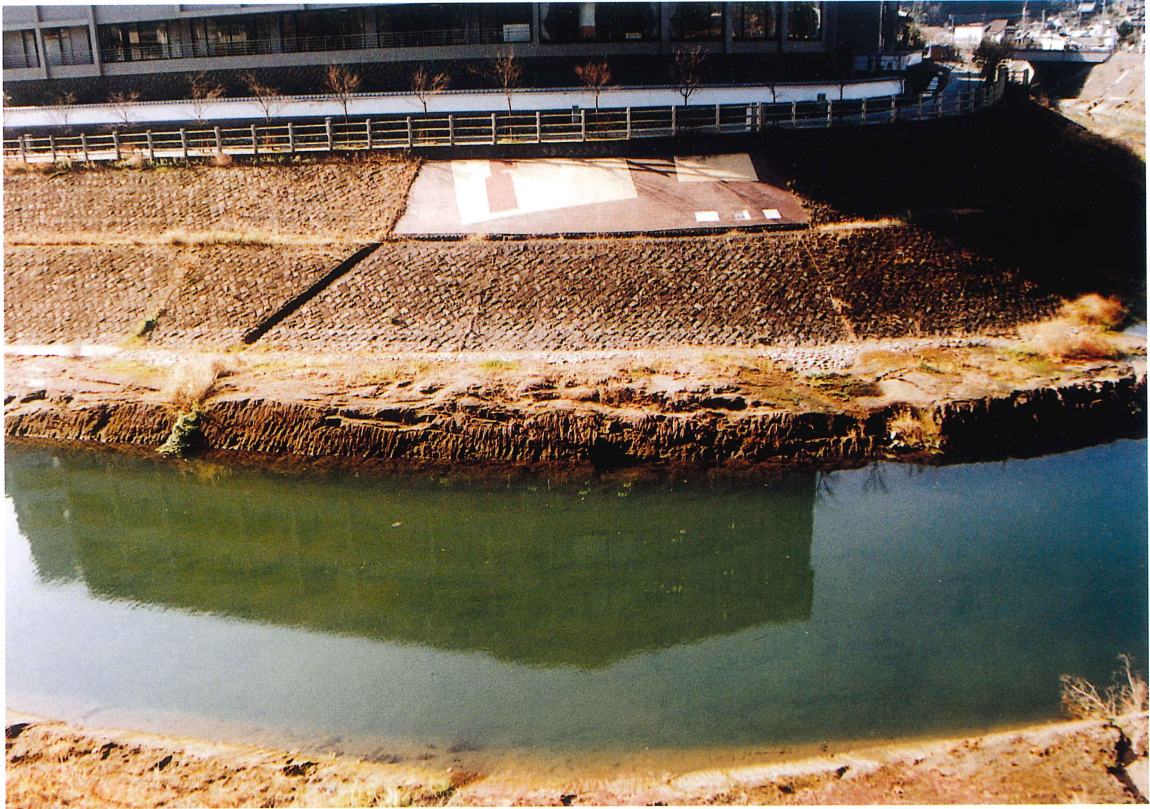
四山社製糸工場跡整備状況
